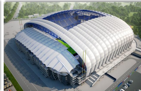
Modernizacja stadionu w Poznaniu
