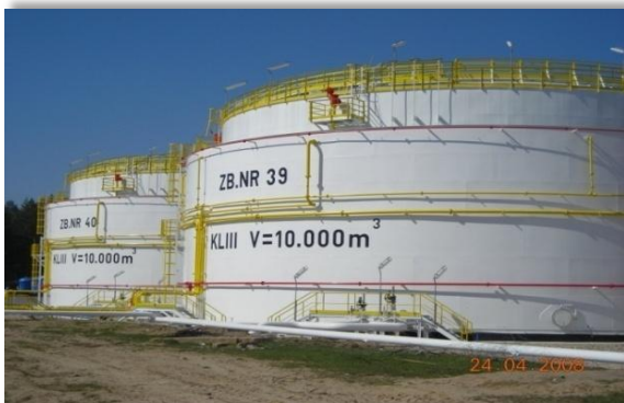
Zbiorniki magazynowe w Rejowcu
